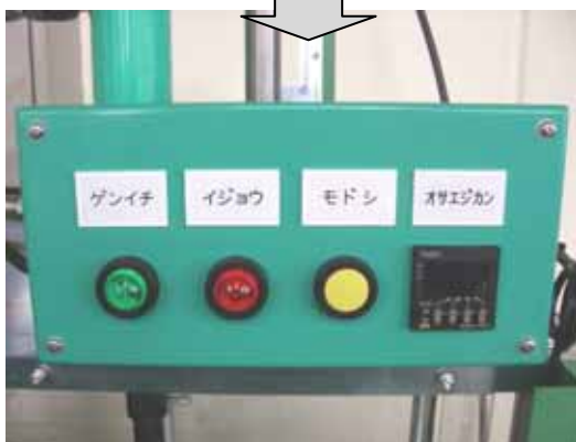
図表 - 4 - 30 1号機のランプボックス
